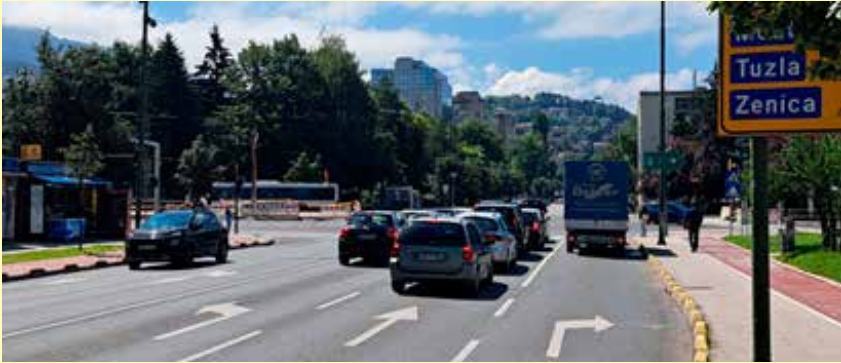
Fotografija 8. Horizontalna signalizacija u višetračnoj klasičnoj raskrsnici
