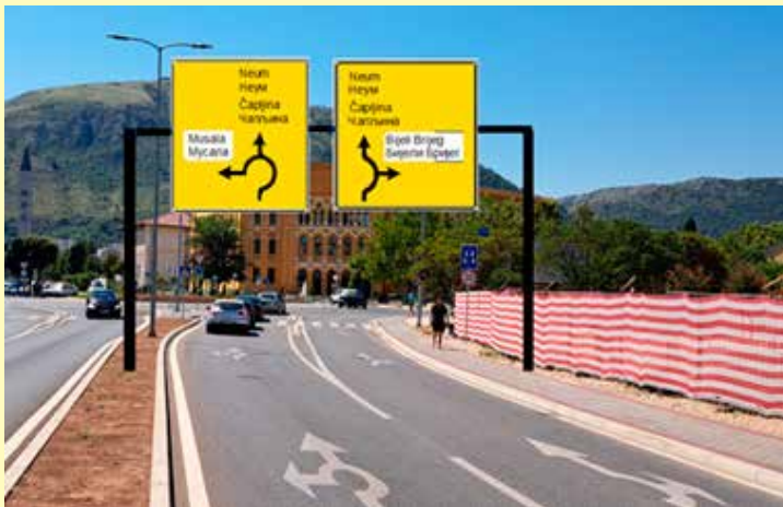
Slika 18. Prijedlog putokaza iznad saobraćajnih traka kod dvotračnog turbo kružnog toka u Mostaru
