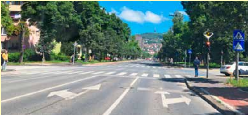
Fotografija 4. Horizontalna signalizacija sa strelicama u raskrsnici
